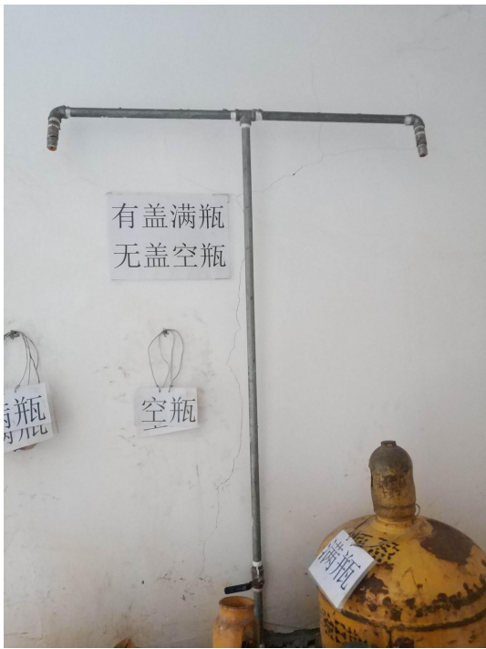
液氨仓库喷淋装置
