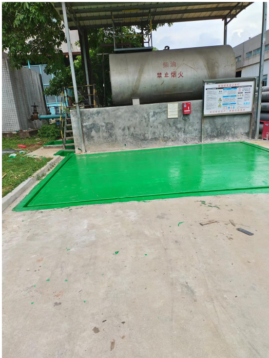
柴油罐区装卸平台（导流沟及收集池）
