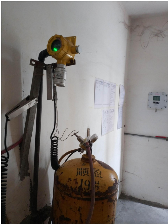
液氨仓库气体泄露报警装置
