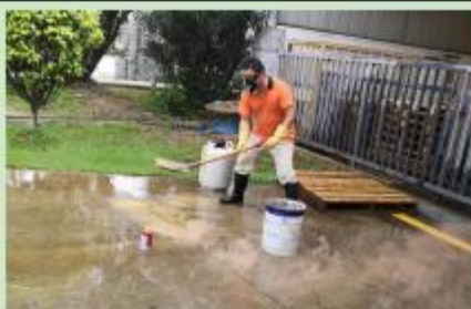
14: 10 用黄沙覆盖泄漏区域，清理现场，黄沙收集到危废桶。
