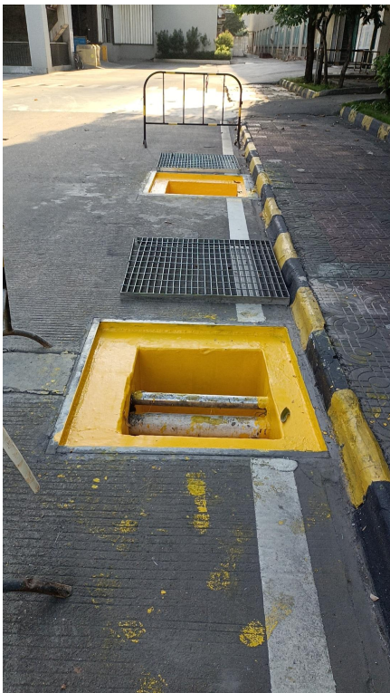
废水输送管道防腐防渗措施
