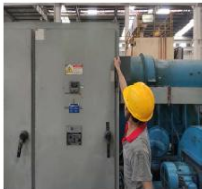
10:02 关闭设备电源和天然气阀
