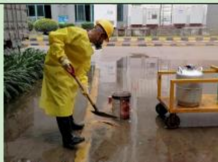
14: 10 用黄沙覆盖泄漏区域，清理现场，黄沙收集到危废桶。
