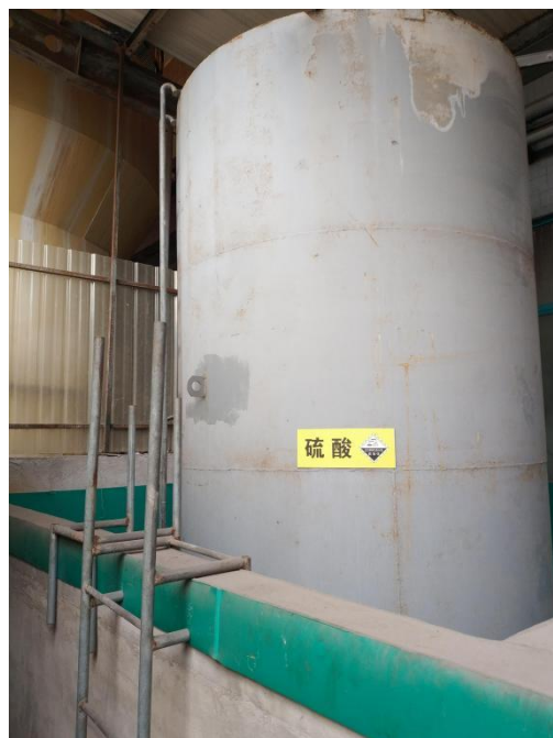
硫酸储罐及围堰
